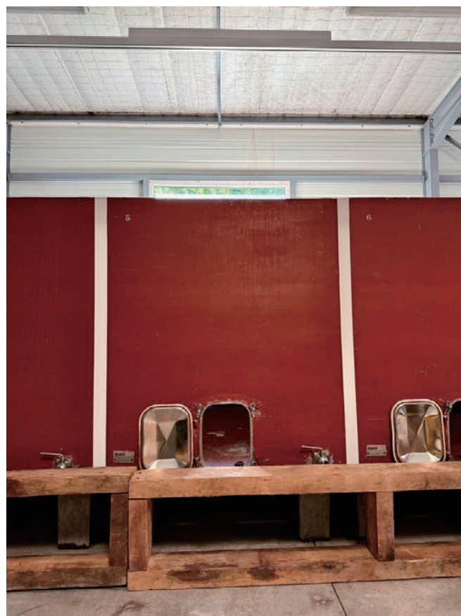
コンクリート製の発酵タンク
